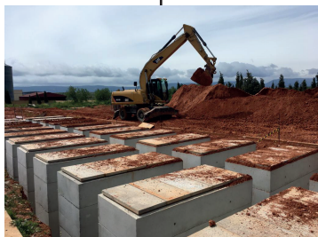
4. Relleno de tierras y solera
