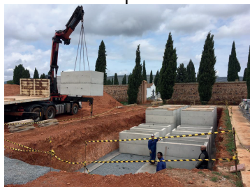
3. Montaje de fosas
