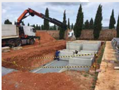
Montaje de fosas
