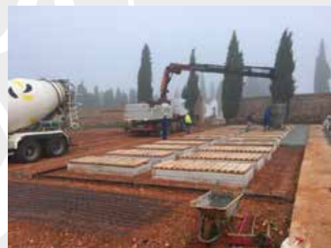
Hormigonado solera
