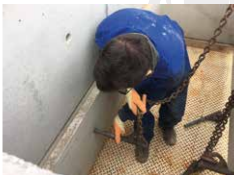
Anclaje de fosas
