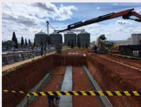
Hormigonado de apoyos
